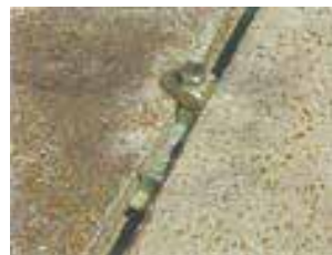
③2枚目の敷鉄板を設置します。
